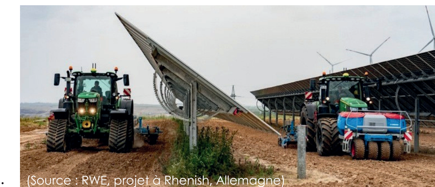
(Source : RWE, projet à Rhenish, Allemagne)
